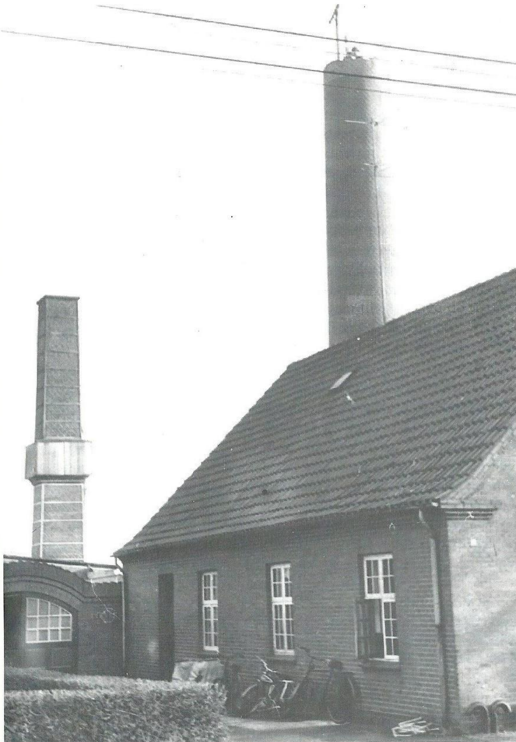
Ny skorsten under opførelse på Gørdning Fjernvarmecentral, november 1960. Foto: Gørdning Sognearkiv.
